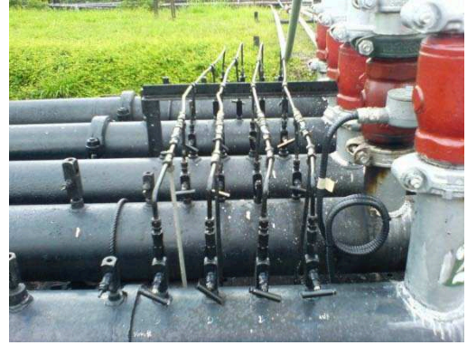
Foto 2. Inyección de Químicos
