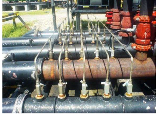
Foto 8. Inyección de Químicos
