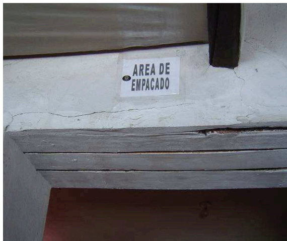
Señalización Informativa – Áreas
