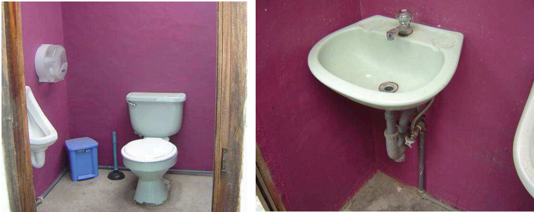
Construcción del baño completo en la planta de procesamiento
