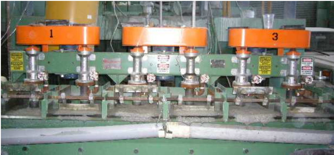
FIGURA 2.9 Banco de celdas de flotación
