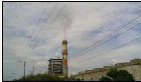
Figura 2.5 : Emisiones Gaseosas de la Planta Termoeléctrica de Esmeraldas
