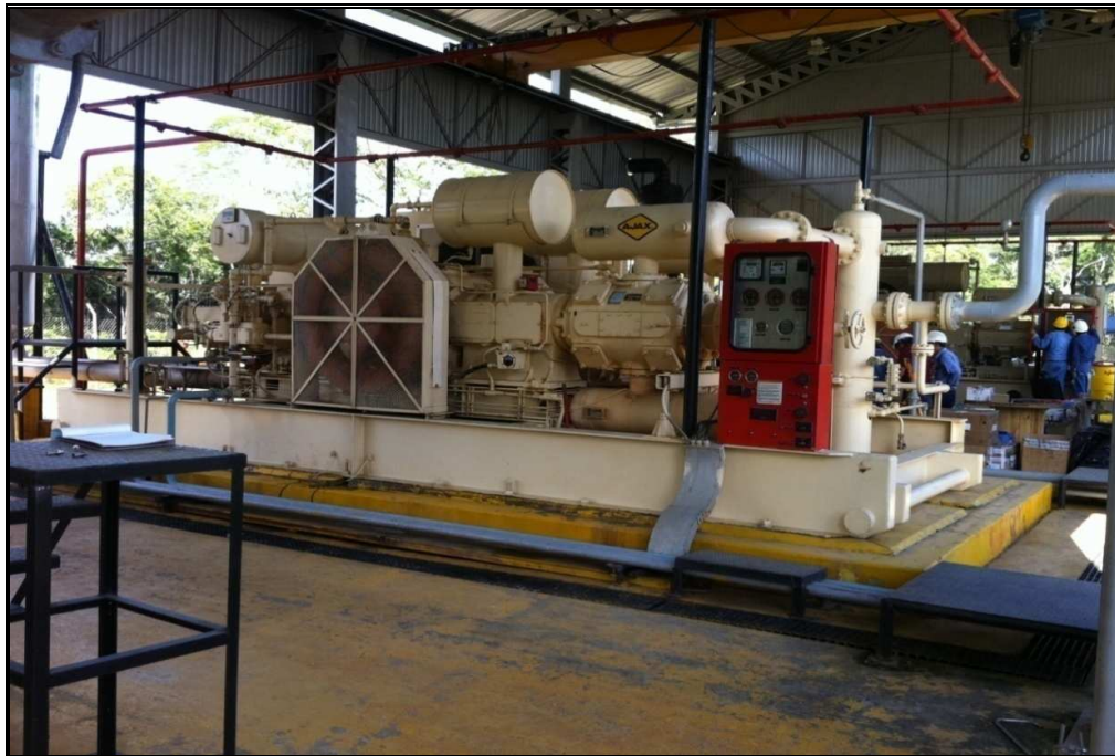
Figura 4.3. Compresor utilizado en la estación de captación de gas Parahuacu
