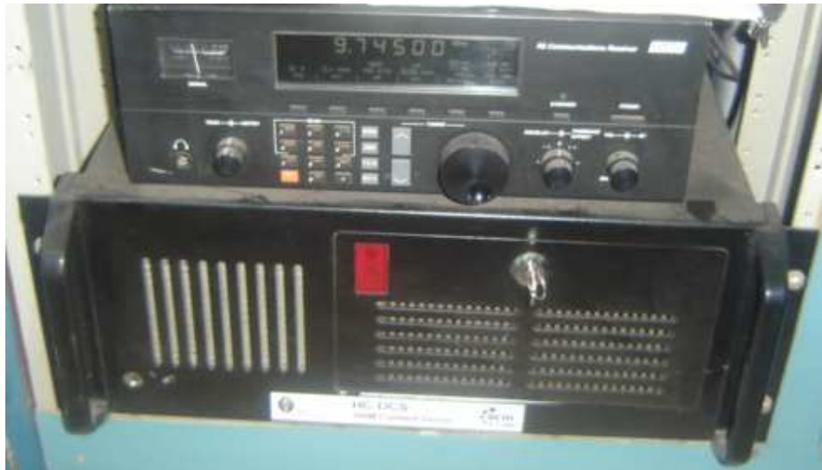
Figura 3.35: Servidor de contenido Harris CSB-100
