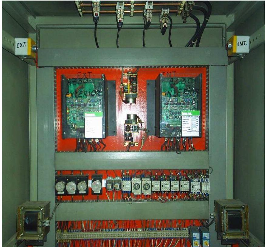
Figura 2.3 Vista del armario de los tornillos dosificadores
