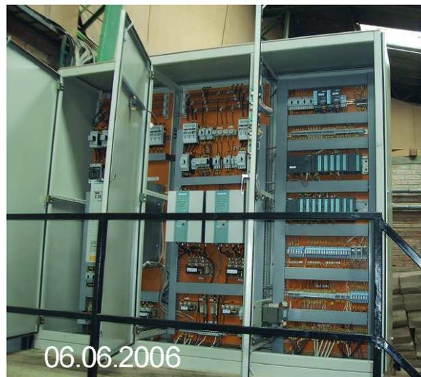
Figura 5.5 Montaje y conexiones finalizadas en el armario eléctrico.
