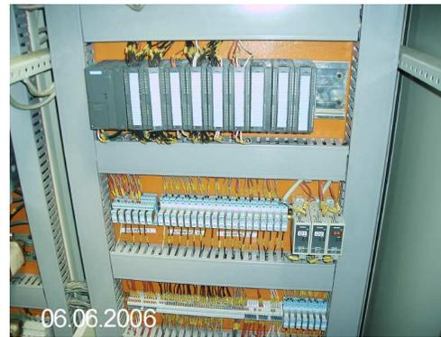
**Figura 5.3 Montaje y cableado del PLC S7 300.**
