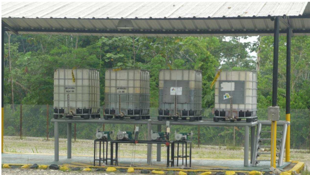
FOTO 10 TANQUES CON QUÍMICOS PARA TRATAMIENTO DE AGUA
