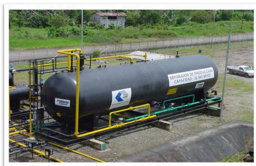
FIGURA 3.2 SEPARADOR TRIFÁSICO
