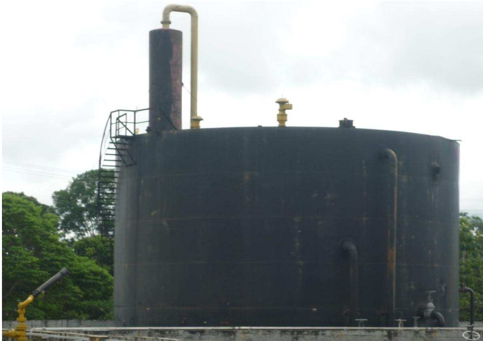
FOTO 4 TANQUE DE ALMACENAJE DE AGUA DE FORMACIÓN
