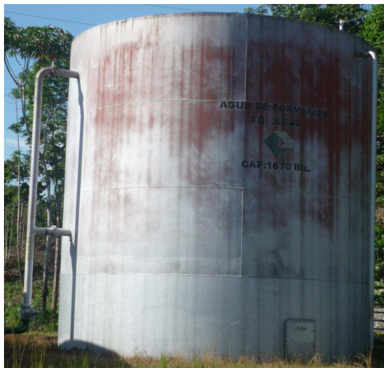
FOTO 4 TANQUE DE ALMACENAJE DE AGUA DE FORMACIÓN
