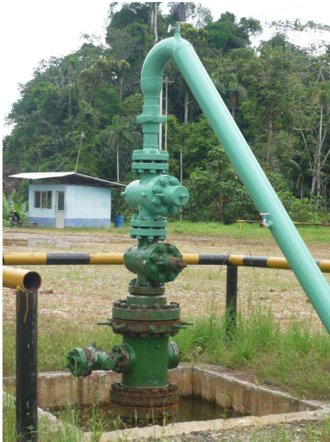
FOTO 11 CABEZAL DE POZO REINYECTOR DE AGUA DE FORMACIÓN CON OXIDACIÓN POR FUGAS DE AGUA
