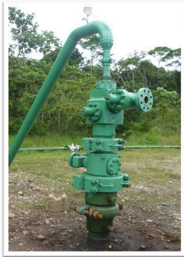
FIGURA 3.10 CABEZAL DE REINYECCIÓN DE AGUA
