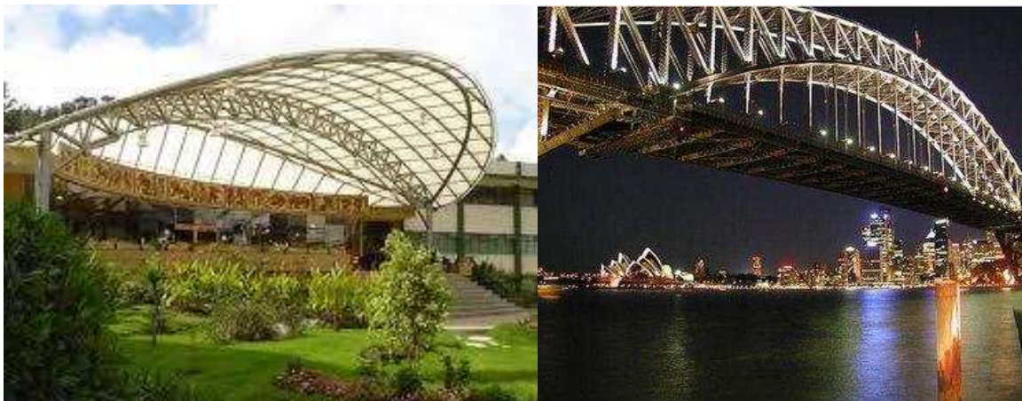
Figura 2.28.- Estructuras de Acero
