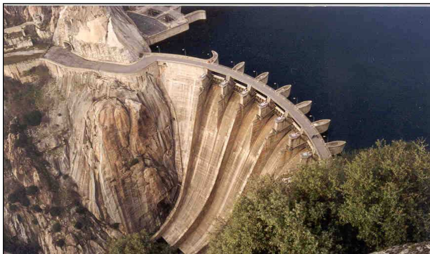
Figura 2. 19. Presa bóveda de ALDEADÁVILA España
