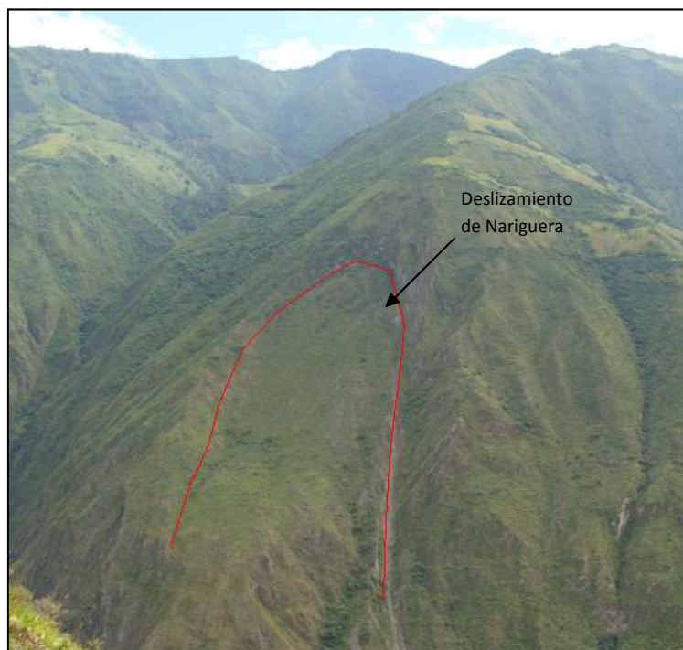
Figura 2. 15. Deslizamiento de Nariguera
