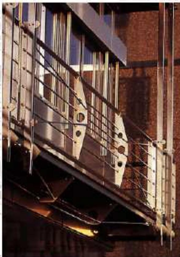
Las superficies externas de los componentes de acero inoxidable se electro-pulieren para facilitar su mantenimiento en esta atmósfera industrial.
