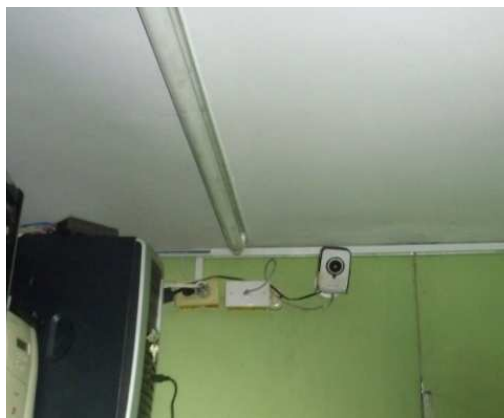
FIGURA 3.19 COLOCACIÓN CÁMARA EN GERENCIA
