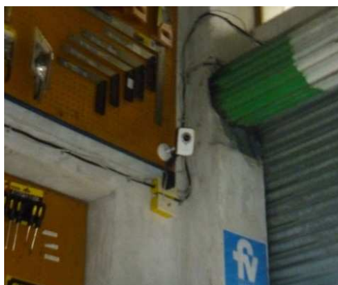
FIGURA 3.18 COLOCACIÓN CÁMARA EN DESPACHO
