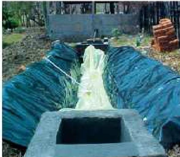
El tubo señalado en ambas cajas es el mismo que está en la estructura del biodigestor. La boca de los tubos que queda afuera, es decir, en las cajas de entrada queda de la siguiente forma:
