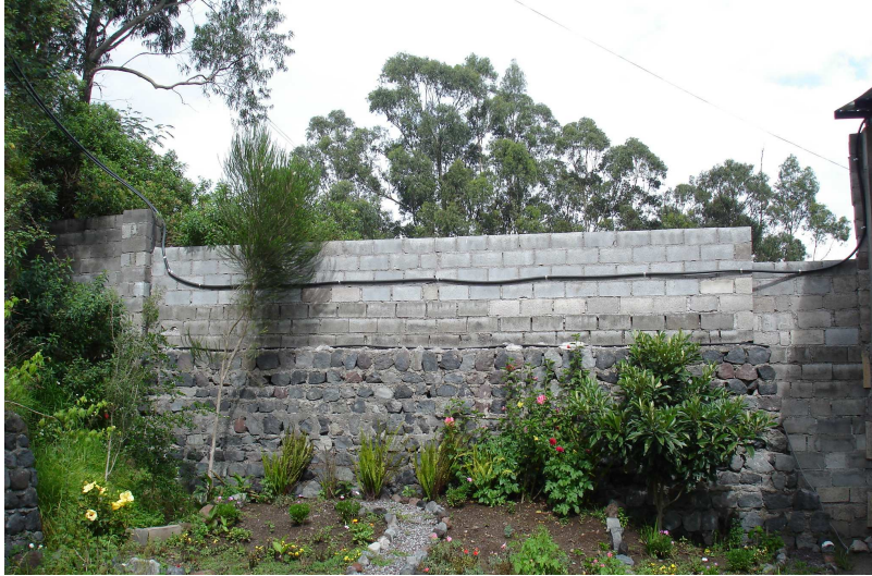
Figura 4-12: Tendido cable UTP de Administración hacia Producción
