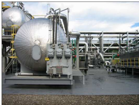
FIGURA 3.7 DESHIDRATADOR ELECTROSTÁTICO
