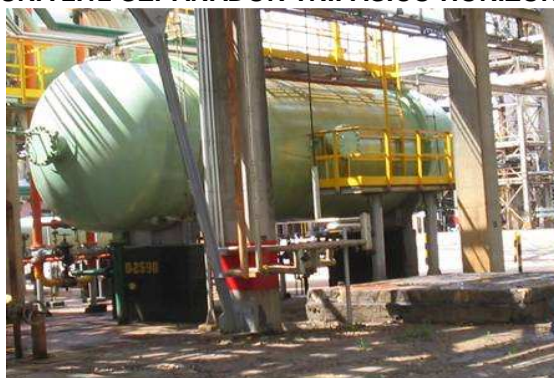
FIGURA 2.12 SEPARADOR TRIFÁSICO HORIZONTAL
