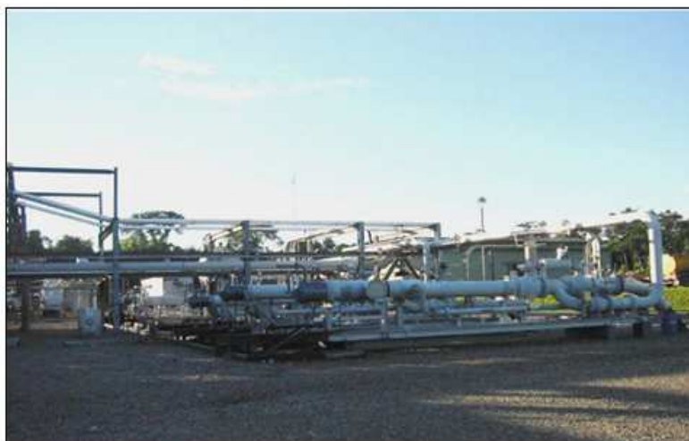
FIGURA 2.4 LANZADOR Y RECIBIDOR DE PIGS
