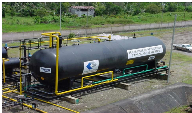
FIGURA 2.9 SEPARADOR DE PRODUCCIÓN
