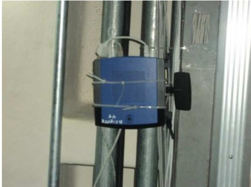
Figura 2. 34 Instalación del router Inalámbrico.
