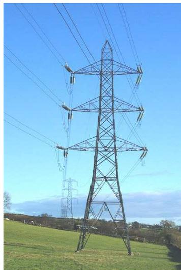
**Figura 2.3 Estructura de retención angular**
