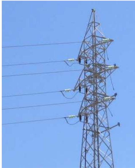
**Figura 2.2 Estructura de retención terminal**
