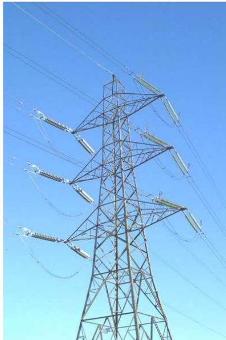
**Figura 2.4 Estructura de retención rompetramos**
