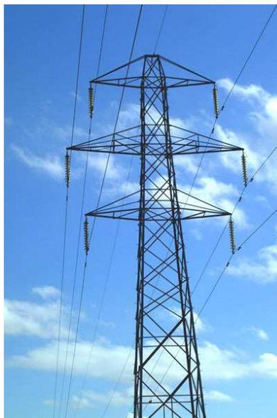
**Figura 2.1 Estructura de suspensión o alineación**
