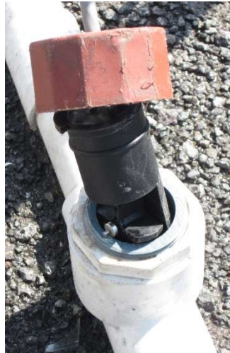
Figura 2.3 Vista del dispositivo para montaje del sensor de Flujo FP7001A. Fotografía tomada en la terraza de la FIM (28-04-2011)
