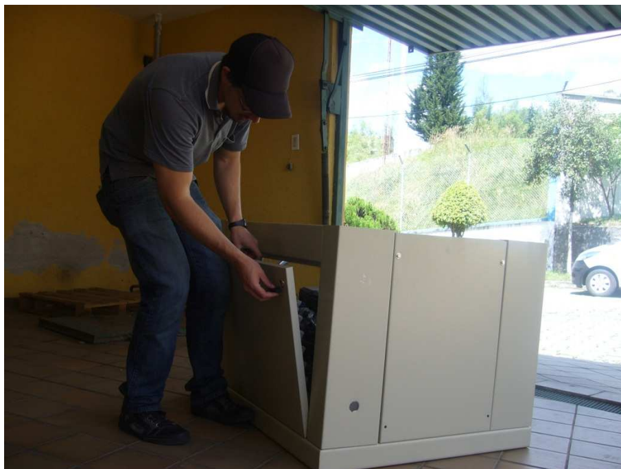
Figura Nº 4.12 Instalación de cabina
