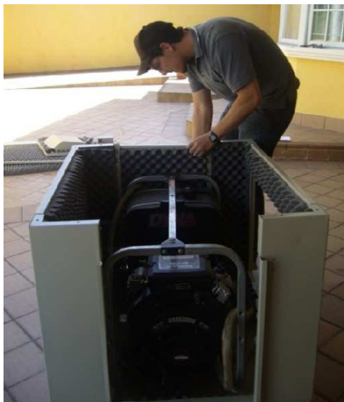
Figura Nº 4.13 Instalación de cabina
