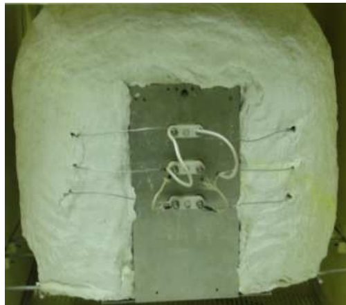
Figura 2-6: Espacio de conexión de las resistencias de calentamiento del horno.
