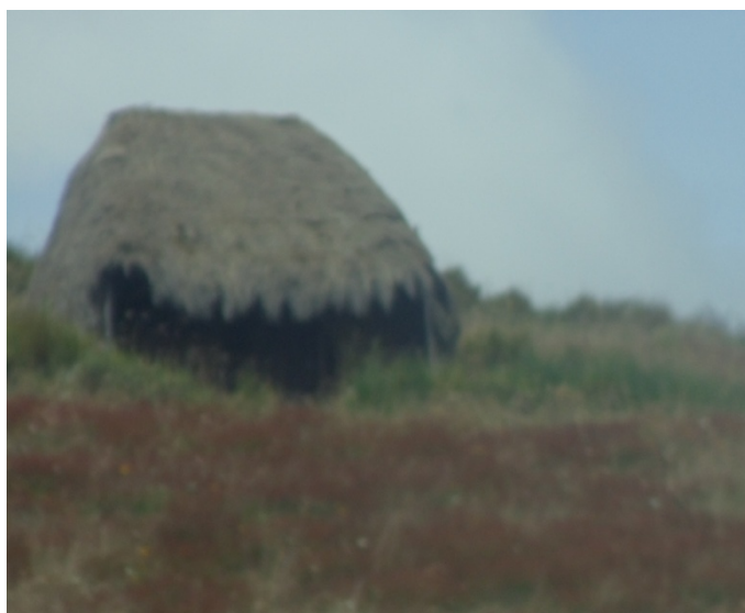
Figura 1.5 Construcción con techo de paja y paredes de adobe, típica combinación.
