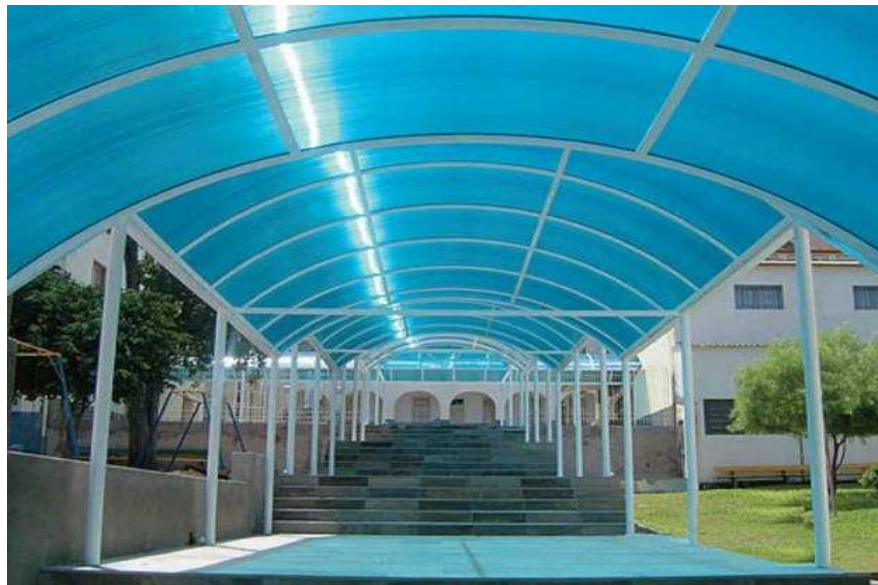
Figura 1.7 Edificaciones realizadas con techos de policarbonato
