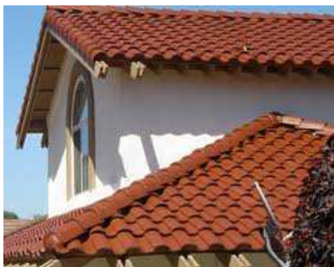
Figura 1.4 Construcción con teja de barro
