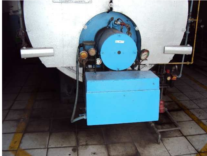
Figura 2.7. 17 Quemador Kewanee Serie F
