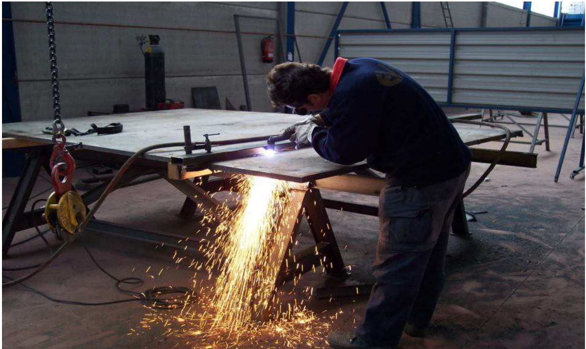
Foto F.1. Corte de las planchas de acero.
