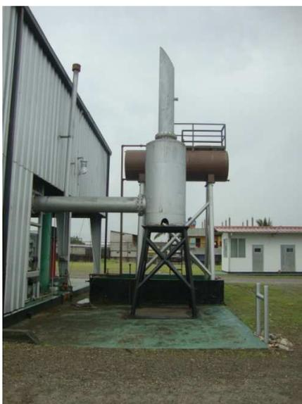
**Fotografía 1.1** Ducto de escape de los motores ALCO
