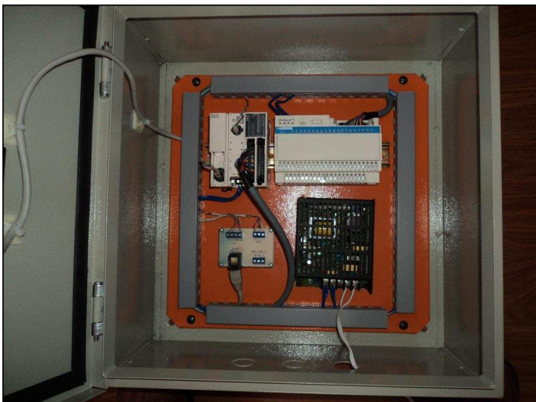
**Figura 4.2.** Tablero de control y monitoreo.
