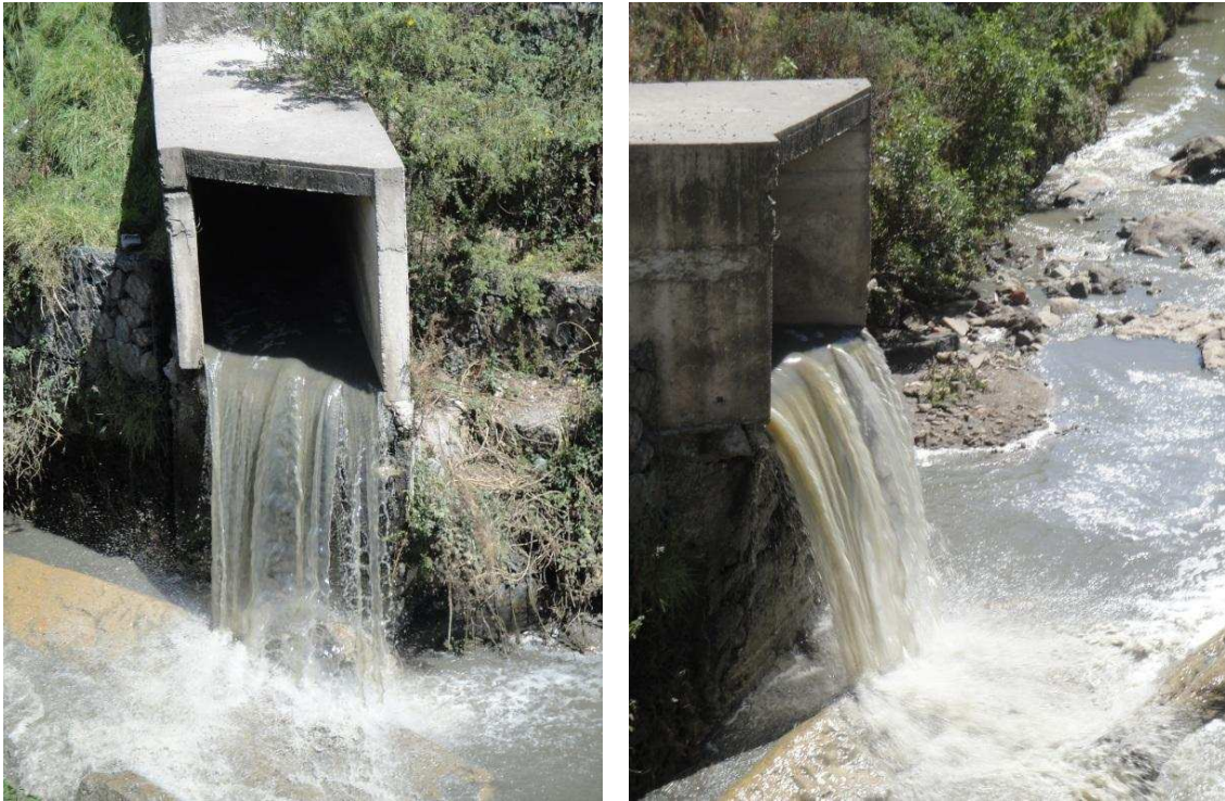
Gráfico 6.21 Estructura de derivación
