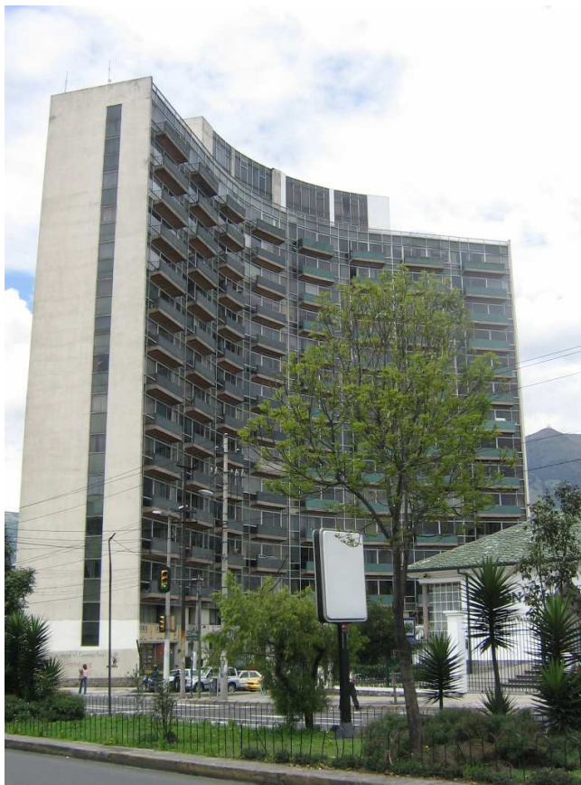
Figura 3.18 Edificio El Girón
