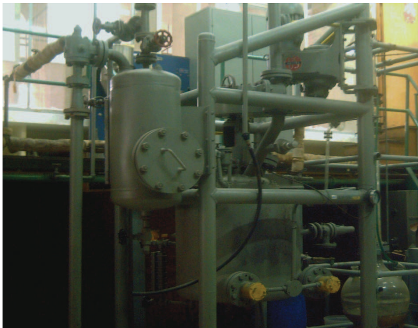
Figura 2.1 Estado original de la planta de reacciones químicas
