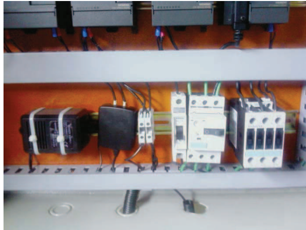
Figura 5.7 Elementos de protección y fuentes externas
