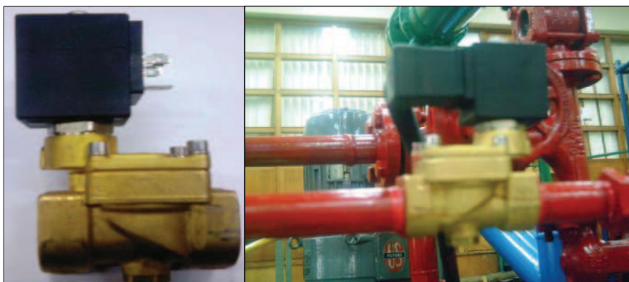
Figura 5.12 Electroválvula para hacer vacío en el tanque
