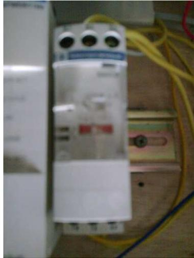
Figura 2.15. Acondicionamiento para sensor conductivo de nivel
