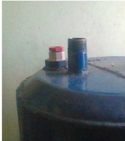
Figura 2.29. Acople para el sensor conductivo
