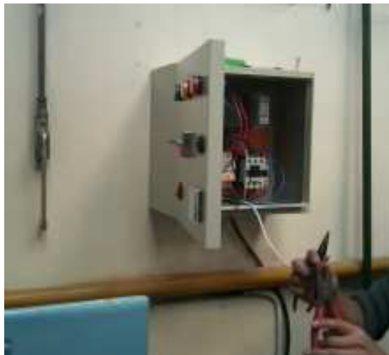
Figura Anexo 4: Instalación de los elementos eléctricos en el gabinete. Fuente Propia.
