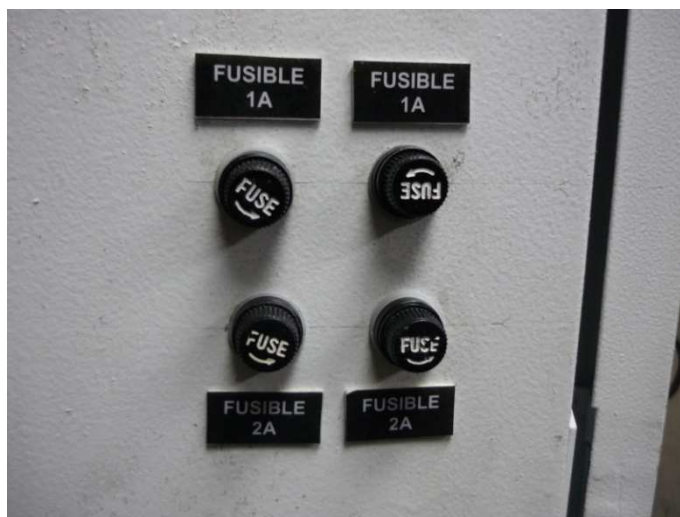
Figura 2.13 Fusibles de protección para el circuito de control
