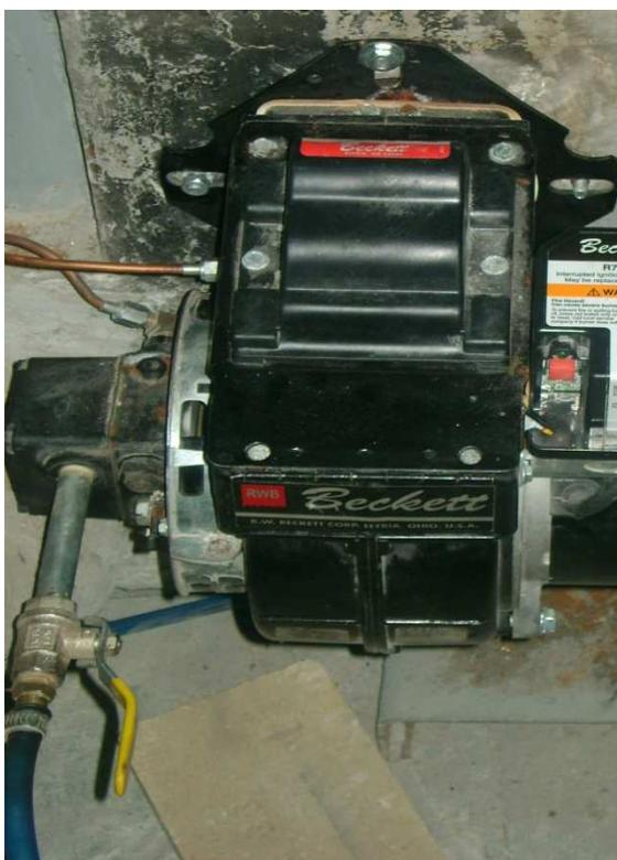
**Figura 70.** Válvula abierta (ON).
