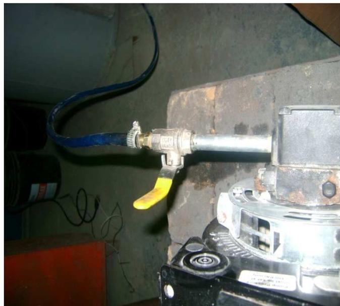
**Figura 54.** Conexión combustible.
