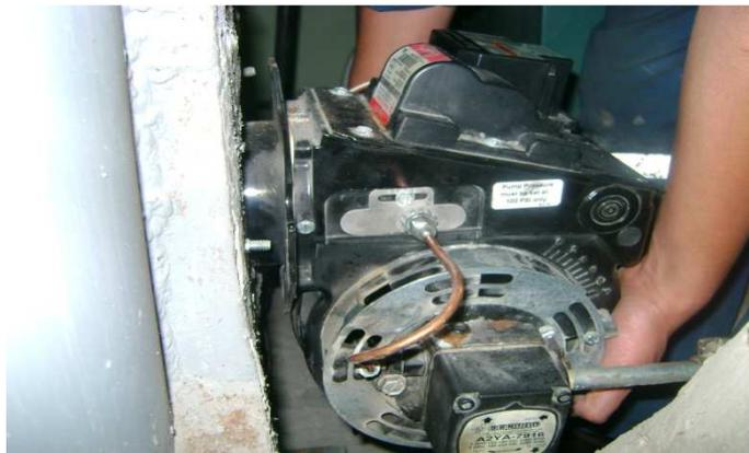
**Figura 48.** Montaje quemador.
