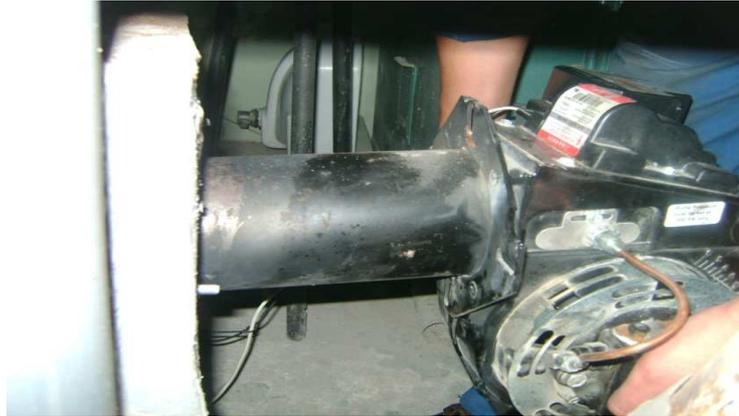
**Figura 47.** Montaje quemador.
