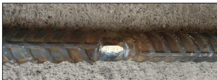
Fotografía 3.7.- Soldadura de las varillas a tope antes del ensayo a tracción
