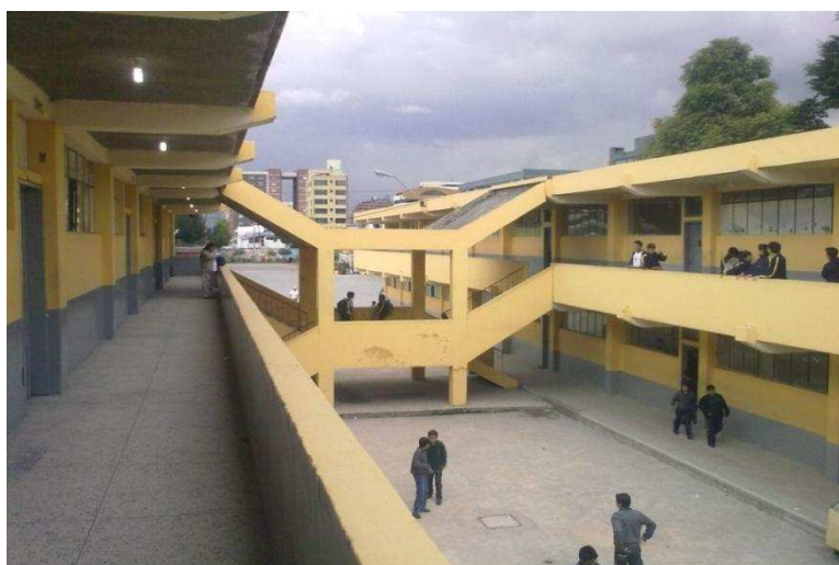
Figura 3.12 Aulas del Instituto
