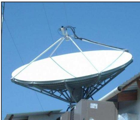
**Fig. 1.3 Antena de foco primario**
