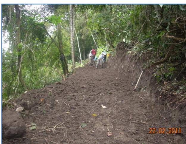
Foto. 3.9. Suelo residual en el sitio de la casa de máquinas del proyecto Chontal (UTM: 752909E, 24890N).
