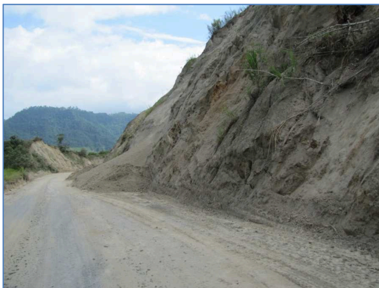
Foto. 3.10. Depósitos de pie de Talud en el corte de la vía Selva Alegre, UTM: 759177E, 25115N.
