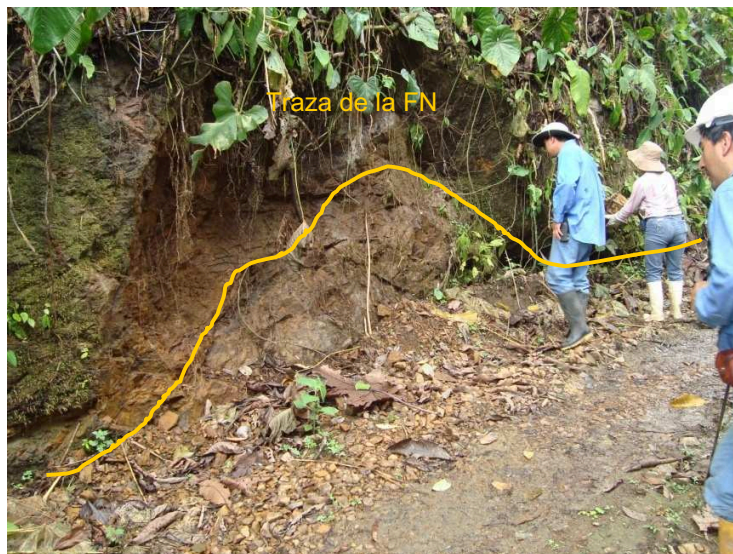
Foto 2.2. Grado de fracturamiento del macizo rocoso que aumenta con la proximidad hacia la Falla Nanegalito (UTM, WGS 84: 770103E, 19594N).
