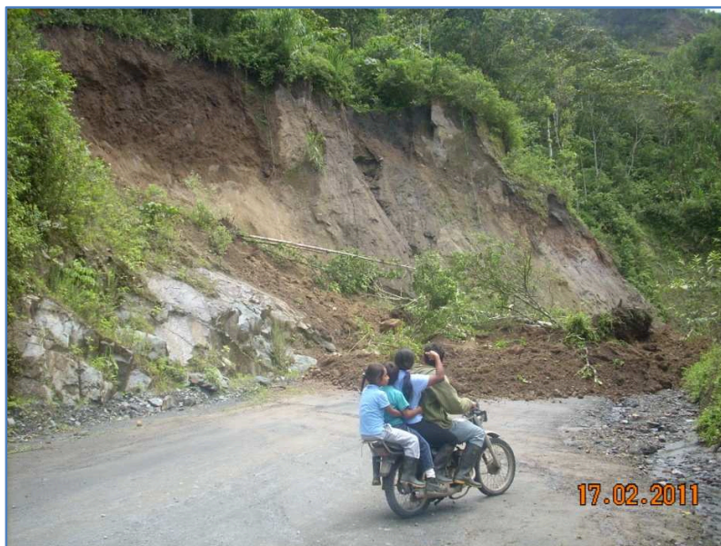
Foto 3. 11 Deslizamiento rotacional. Ubicado en el Kilómetro 20 de la vía Selva Alegre Saguangal, obstruyó el paso por cinco días debido a la falta de maquinaria para movilizar el material (UTM: 758485E, 24668N).
