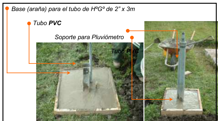
Figura 4 Soportes Instalados
