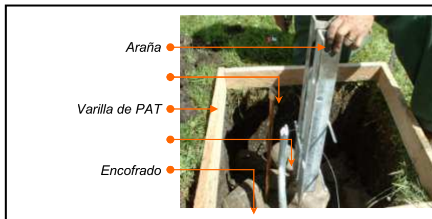
Figura 3 Fundición de Base de Soporte para Estación
