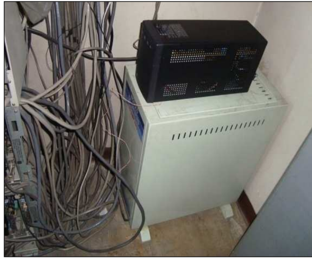
Figura 2.17 Central telefónica de Laboratorios LIFE
