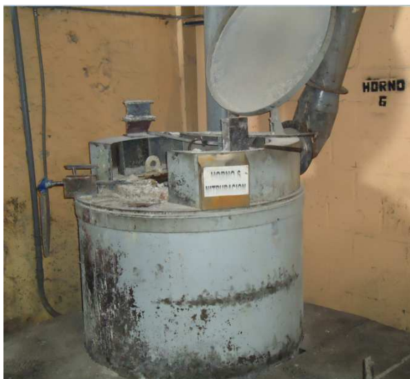
Figura 3. 19 Horno N5 para enfriamiento isotérmico a 500°
