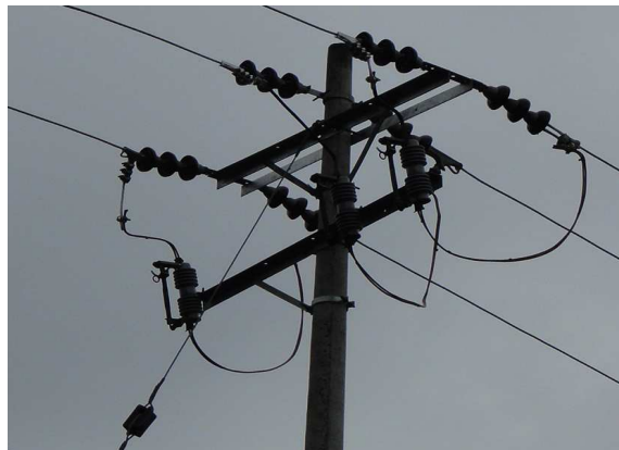
Figura 2.24 Montaje tipo MVF2
