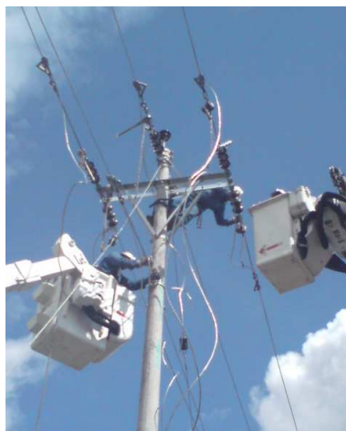
Figura 3.75 Regulación del conductor
