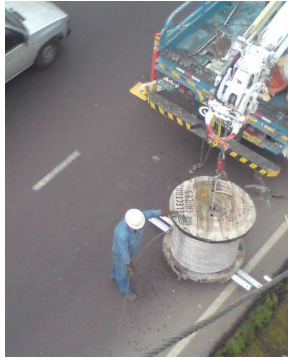
Figura 3.69 Desenrollado del conductor
