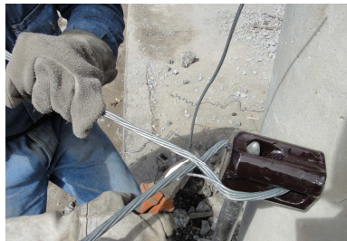
Figura 3.51 Entorche del cable tensor
