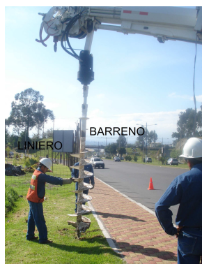
Figura 3.5 Inicio de la perforación
