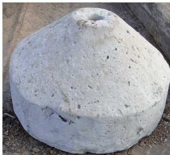
Figura 2.8 Bloque de anclaje cónico
