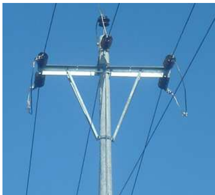
Figura 2.44 Estructura tipo RVA3
