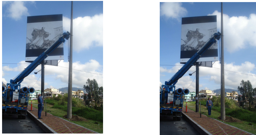
Figura 3.10 Aplomo de los poste
