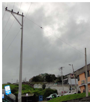
Figura 2.3 Tensor de poste a poste
