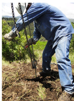
Figura 3.62 Introducción de la llave de pico en el tensor
