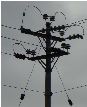
Figura 2.31 Derivación RVA4 – RVA4
