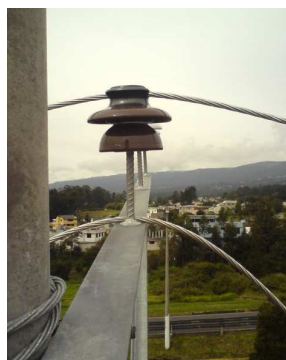
Figura 3.72 Colocación del conductor en los aisladores
