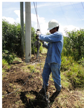
Figura 3.60 Sujeción del tecele al cable tensor
