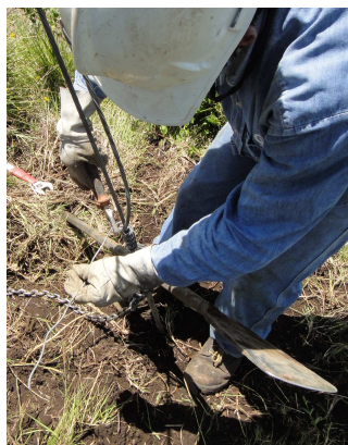
Figura 3.64 Entorche del cable tensor
