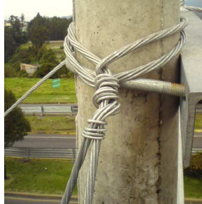
Figura 3.55 Entorche del cable tensor
