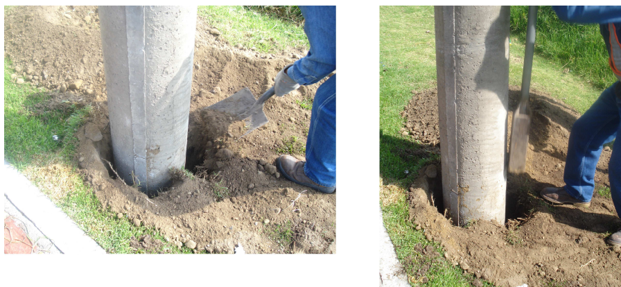
Figuras 3.11 Relleno y apisonamiento de la tierra
