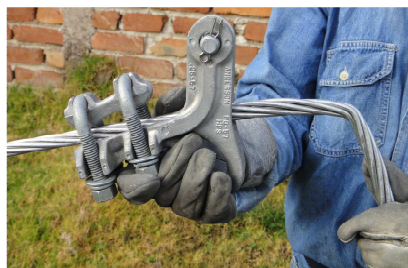
Figura 3.71 Doblez del conductor
