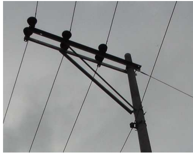
Figura 2.39 Estructura tipo RVB2
