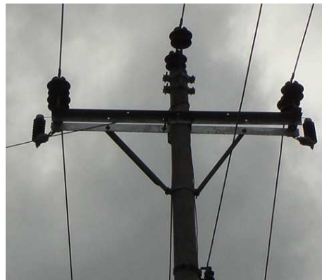
Figura 2.42 Estructura tipo RVA2
