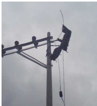
Figura 3.54 Instalación del cable tensor
