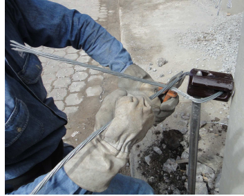
Figura 3.50 Muesca en el aislador de retenida
