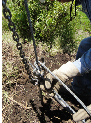
Figura 3.63 Introducción del tensor al ojal
