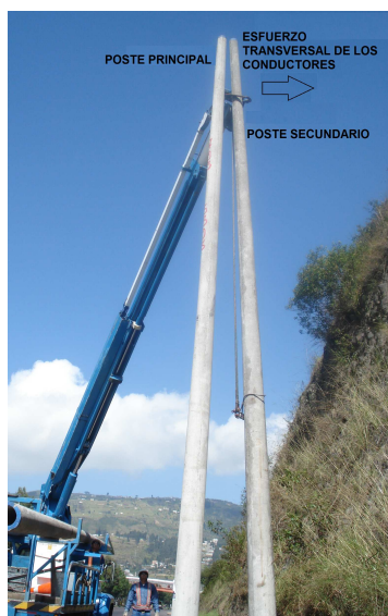
Figura 3.12 Poste con estructura en “A”
