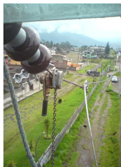
Figura 3.74 Anclaje del conductor con tecele
