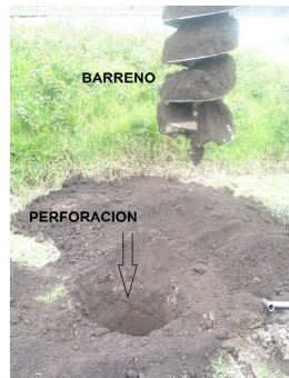
Figura 3.6 Extracción de la tierra
