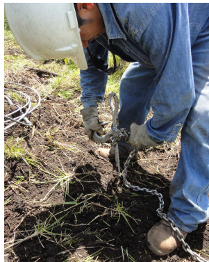
Figura 3.59 Amarre de la cadena del tecele al ojal
