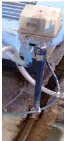
Figura 1.7 Presostato
