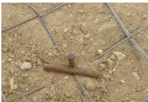
Figura 61. Sujetador de la malla electrosoldada al talud
