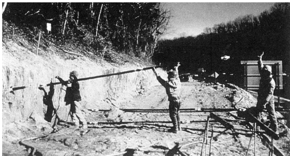
Figura 56. Excavación inicial e instalación del anclaje
