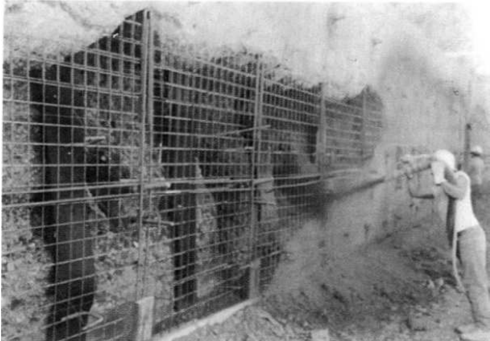
Figura 62. Revestimiento de muros anclados
