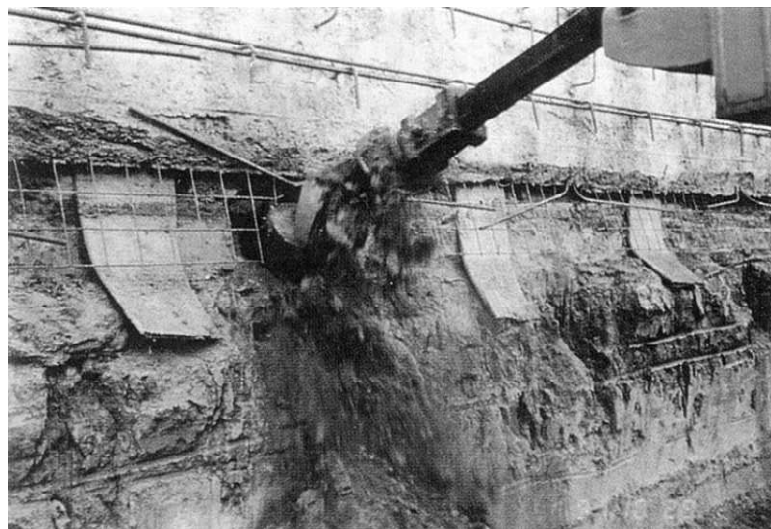
Figura 31. Tiras de drenaje bajo el concreto lanzado temporal
