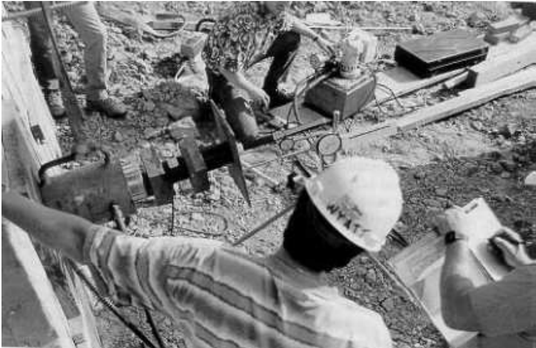
Figura 64. Operaciones de las pruebas de carga
