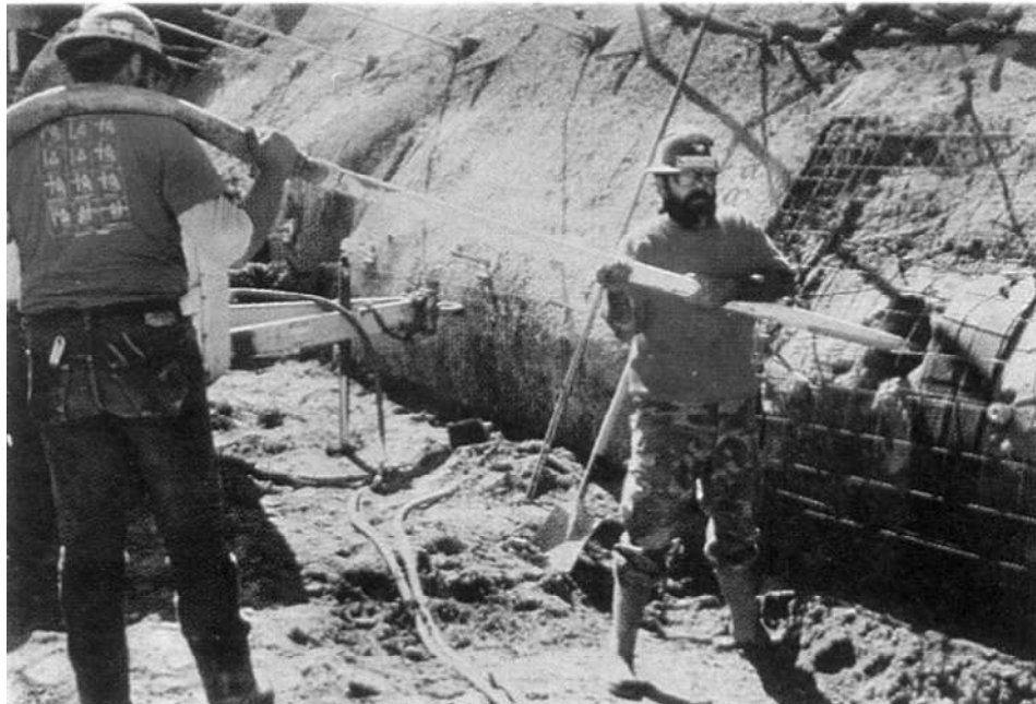
Figura 60. Inyección de lechada a través de un tubo
