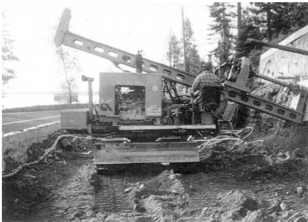
Figura 59. Método de perforación a rotación
