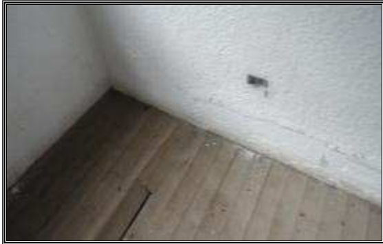
SUBSUELO 2, NIVEL 00-3,70. HABITACIÓN 1.
