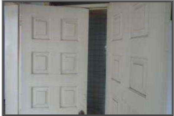
PLANTA ALTA, NIVEL 00+2,55. DORMITORIO.
