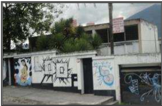
INGRESO A LA VIVIENDA CALLE AYARZA.
