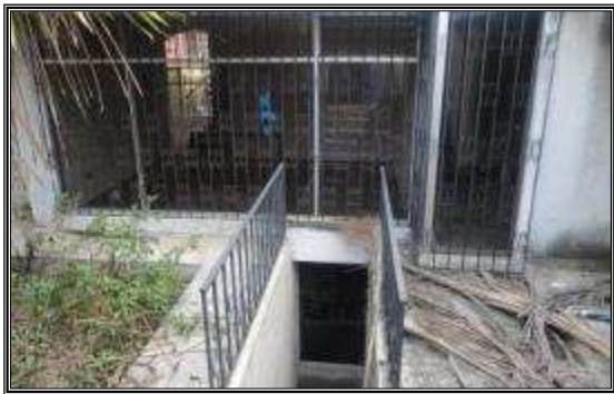
PLANTA BAJA, NIVEL 00+00. PATIO FRONTAL.
