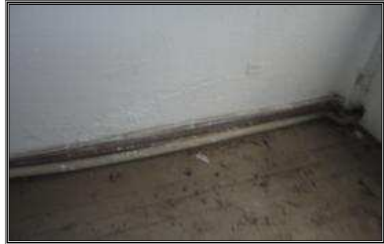
SUBSUELO 2, NIVEL 00-3,70. HABITACIÓN 2.
