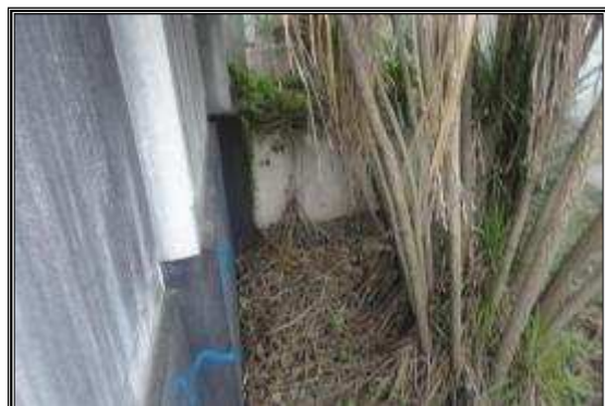
PATIO FRONTAL, NIVEL 00+1,20.
