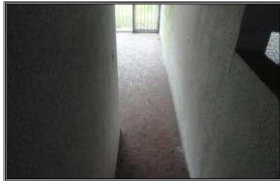
SUBSUELO 2, NIVEL 00-3,70. HALL DE INGRESO.
