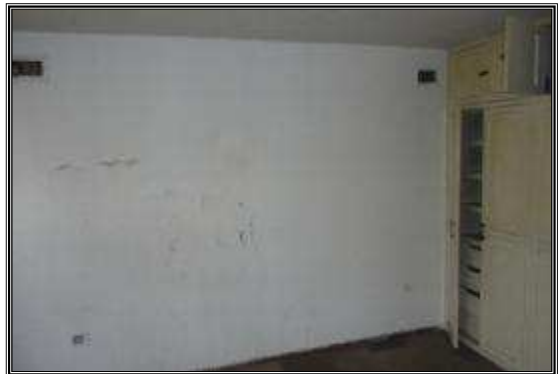
PLANTA ALTA, NIVEL 00+2,55. DORMITORIO.
