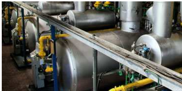
Figura 2.4 Retorno de Condensado
