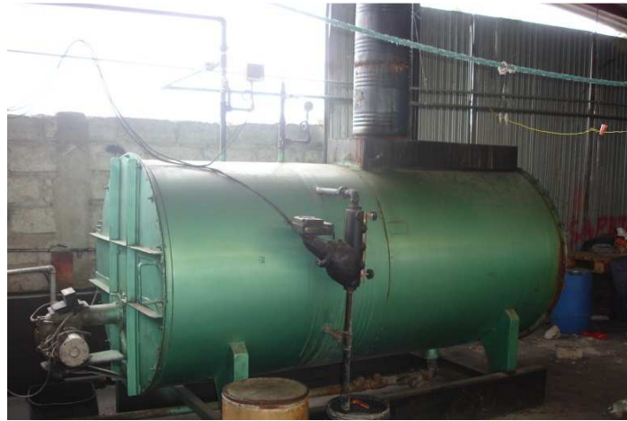
Figura 1.3 Caldero pirotubular de tubos de fuego [Fuente: Duck's colors P & M]
