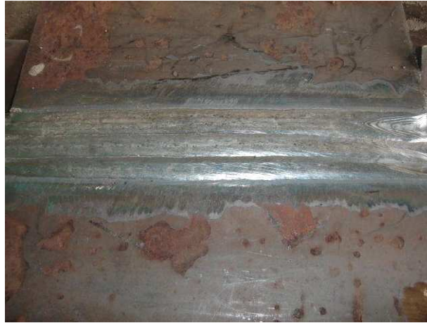
Figura 4. 32 Soldadura de Cara con Tres Pases
