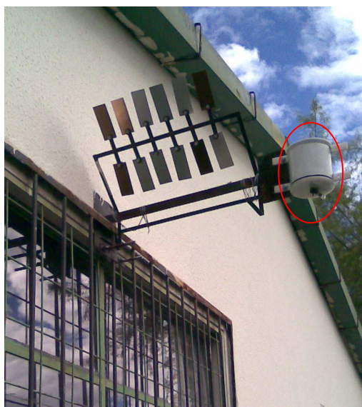
Figura 10. Sensor de monitorización pasiva, estación Quitumbe
