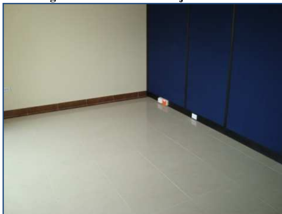
Figura 4-36 Área de trabajo terminada
