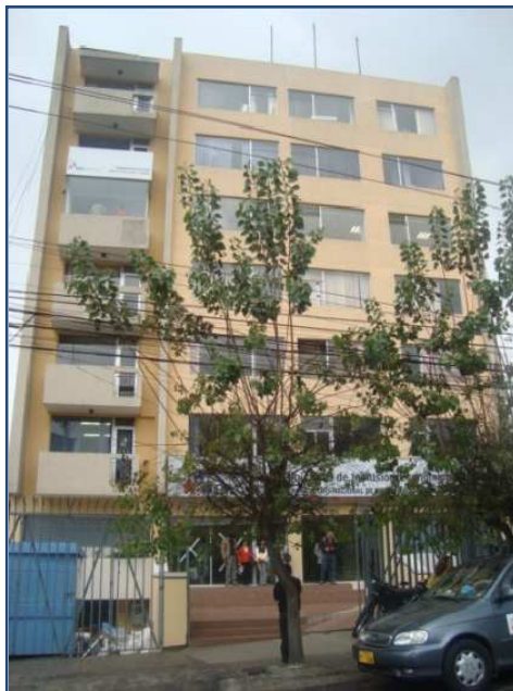
Figura 2-2 Nuevo edificio donde se trasladará el PPA (cuarto piso).
