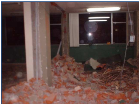
Figura 4-1 Verificación de las nuevas instalaciones del PPA
