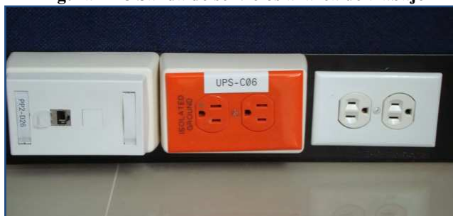
Figura 4-18 Salida de servicios al área de trabajo
