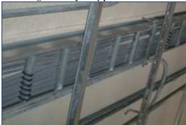
Figura 4-3 Sujeción y peinado del cable
