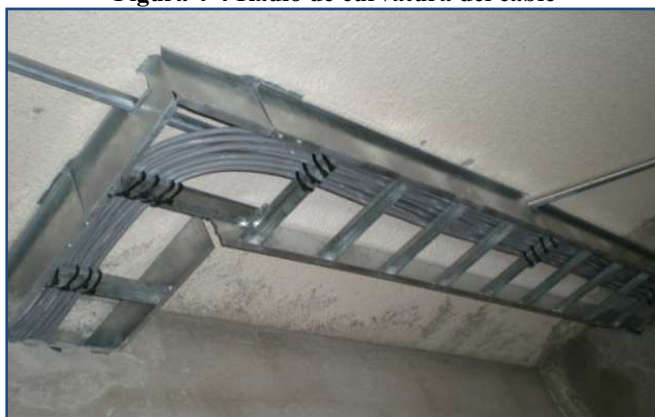
Figura 4-4 Radio de curvatura del cable
