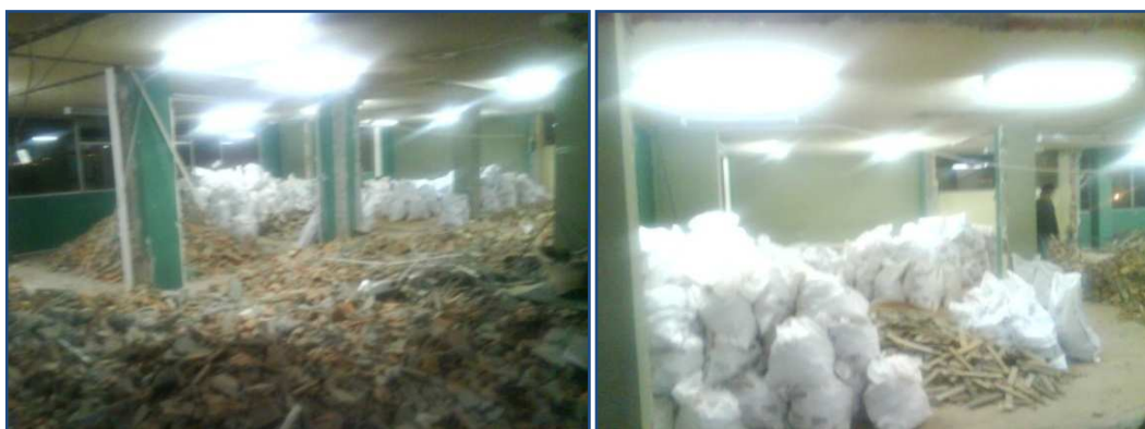
Figura 2-3 Etapa de remodelación de las nuevas instalaciones (cuarto piso).
