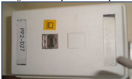
Figura 4-23 Etiquetado en faceplate
