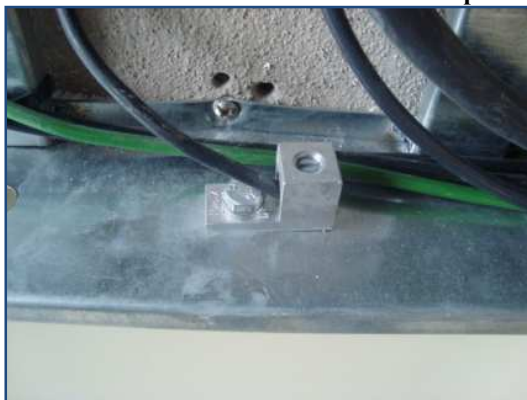
Figura 4-20 Conexión de la canaleta al sistema de puesta a tierra
