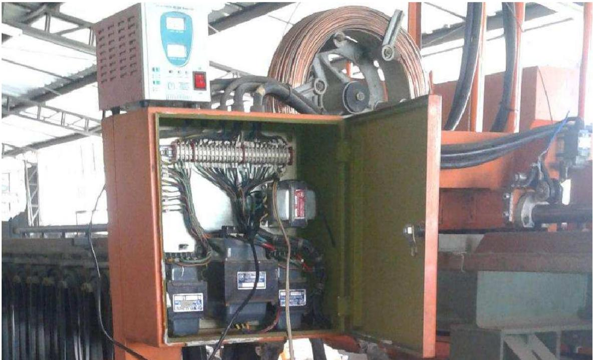
**Figura 4.19.**Regulador de voltaje utilizado en las pruebas de soldadura.
