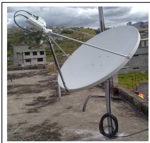
Fig. 2.49 Ubicación del Feed, LNB, Odu RF
