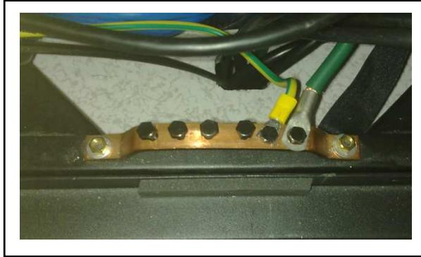
Fig. 2.36 Polarización de la IDU
