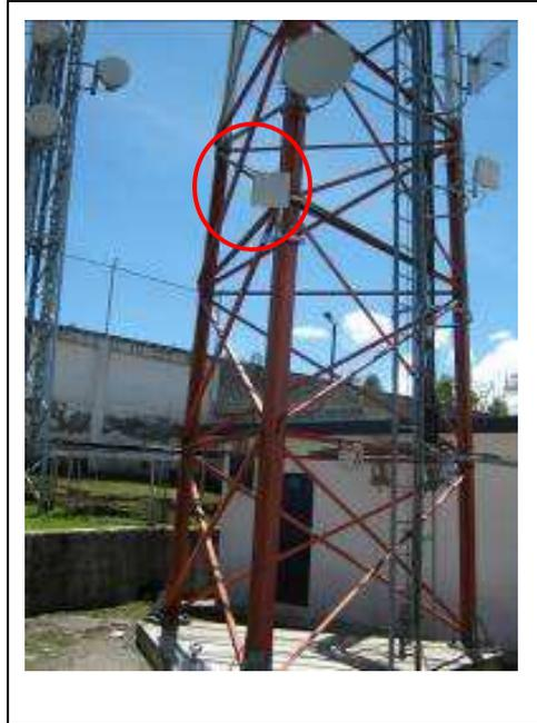
Fig 2.3 Antena instalada en la RBS Guajalo
