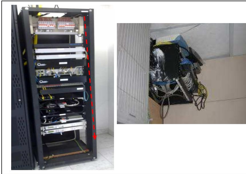
Fig. 2.8 Recorrido del cable hasta la ubicación del equipo IDU en la RBS y Cliente
