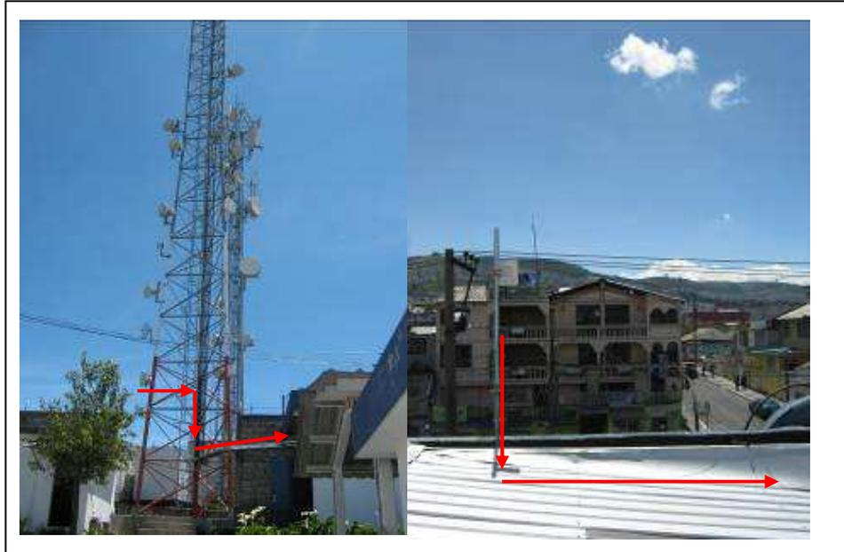
Fig. 2.6 Recorrido del cable de datos en la RBS Y Cliente
