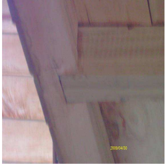
Imagen 002.- Detalle de destaje.
