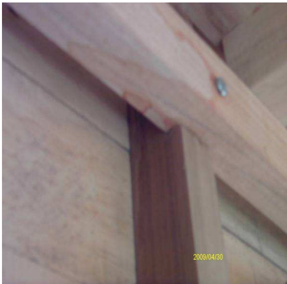
Imagen 003.- Detalle de destaje.
