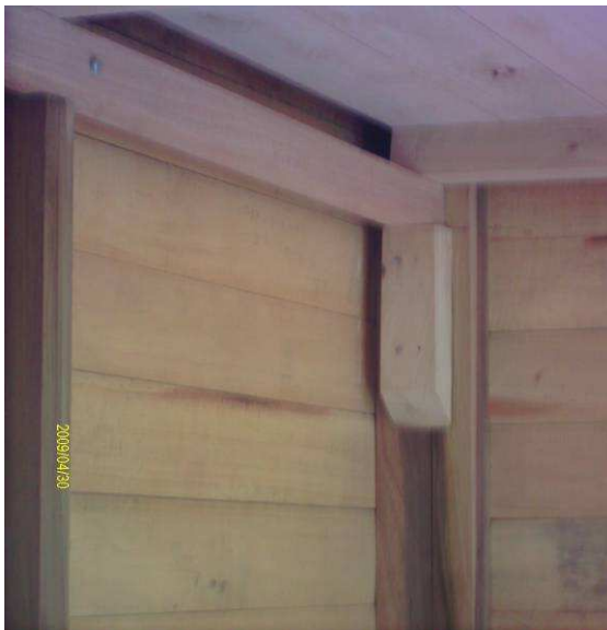
Imagen 011.- Detalle aseguramiento vigas.
