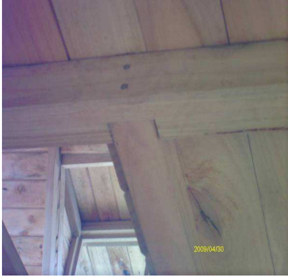
Imagen 001.- Detalle de destaje.
