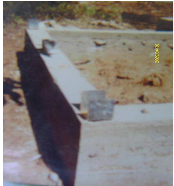
Imagen 008.- Detalle fundido pletinas.
