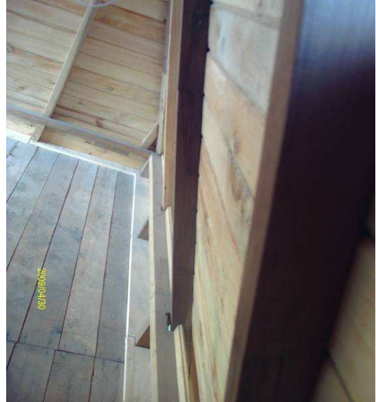
Imagen 006.- Detalle de destaje.
