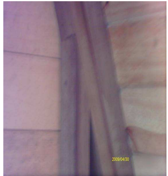
Imagen 004.- Detalle de destaje.
