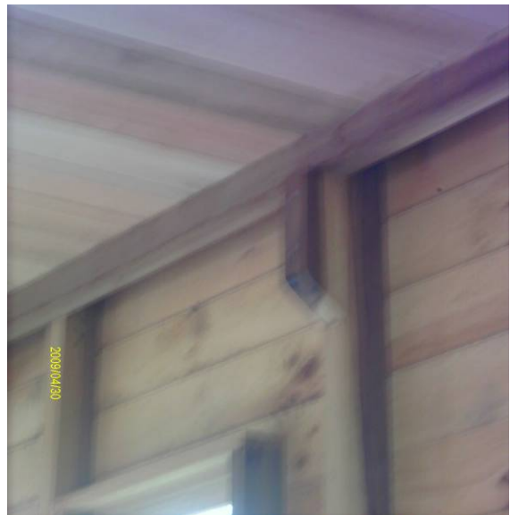
Imagen 012.- Detalle aseguramiento vigas.
