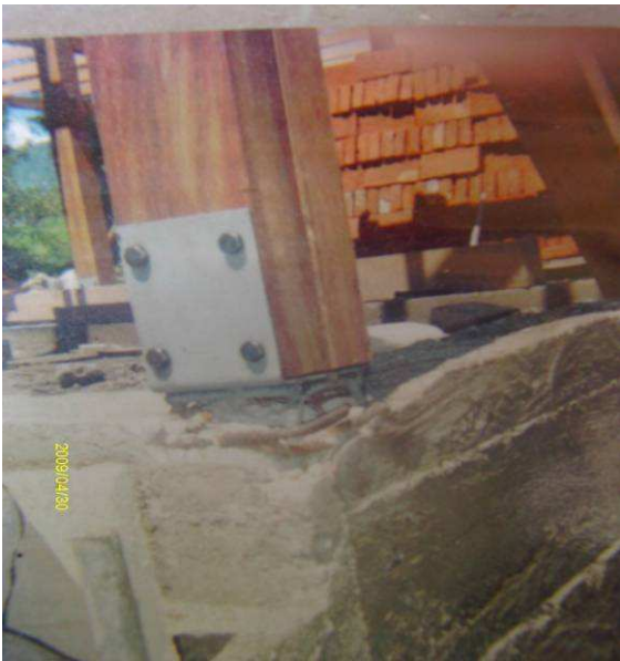
Imagen 007.- Detalle unión columna-base.
